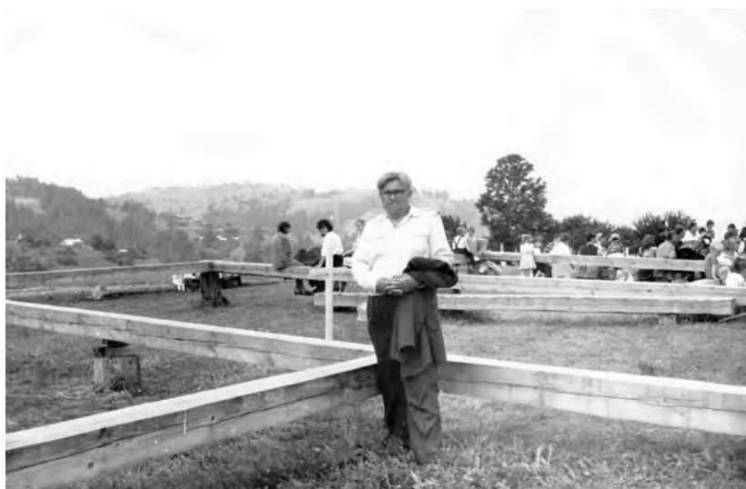
Будівництво церкви св. пророка Іллі в с. Головах
