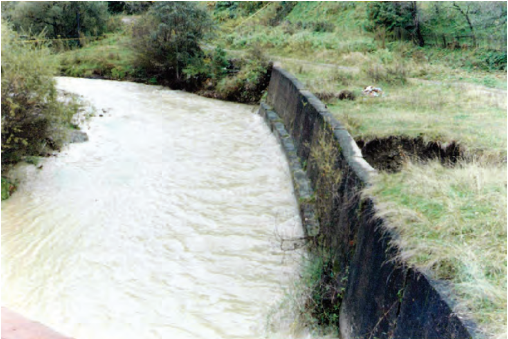
Рис. 6 – Залізобетонні берегові кріплення – підпірні стінки з тривалим терміном експлуатації у районі мостів на малих гірських річках Потік і Виженка – притоках р. Черемош
