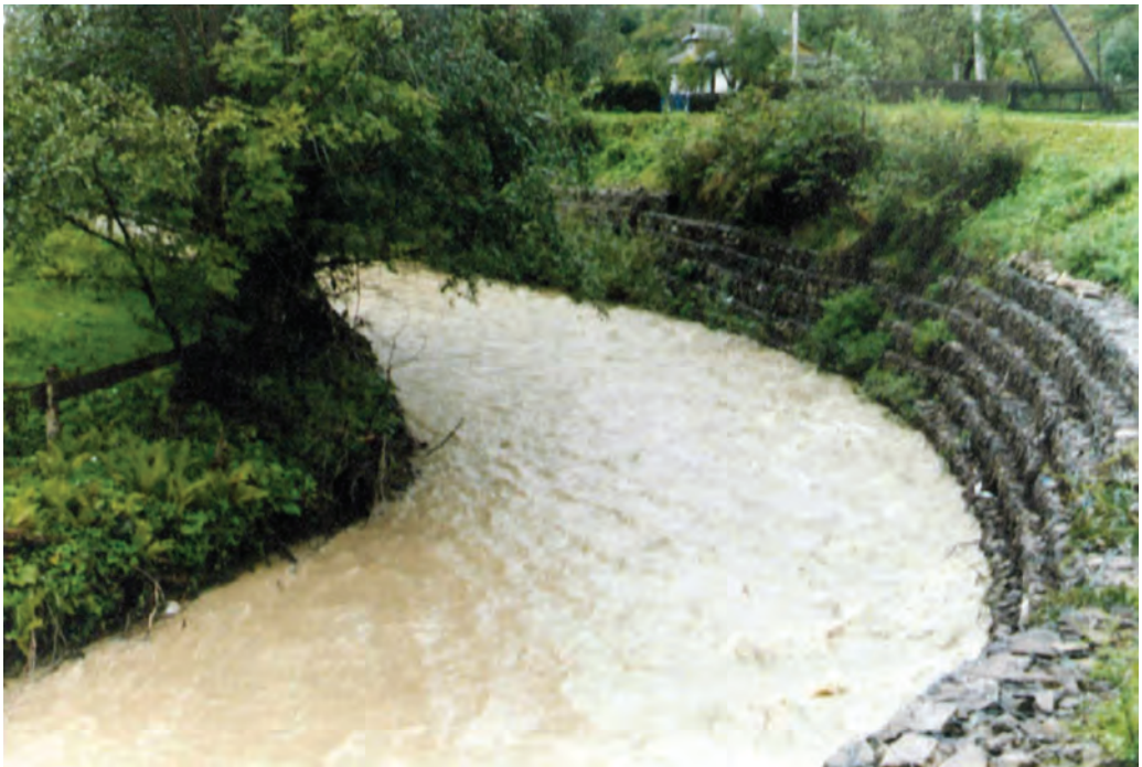
Рис. 3 – Габіони – берегоукріплення на р. Великий Рожен (ліва притока р. Черемош)
