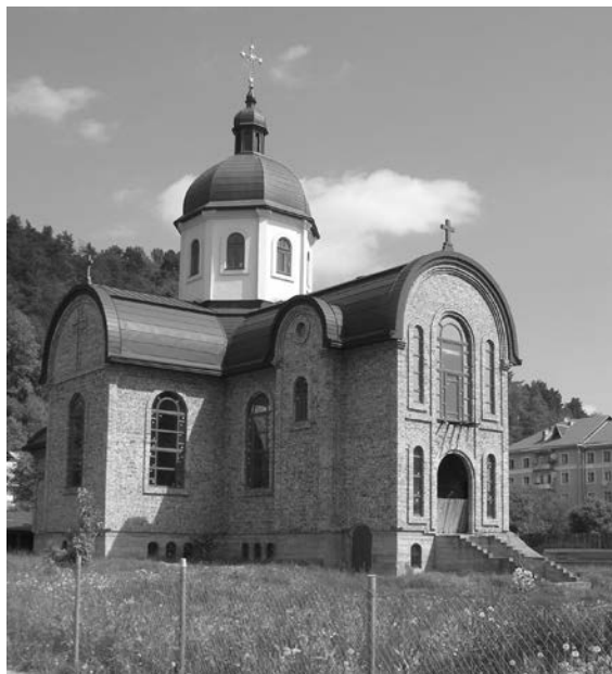
Нова церква, яка будується на місці колишньої міської церкви Пресвятої Трійці
