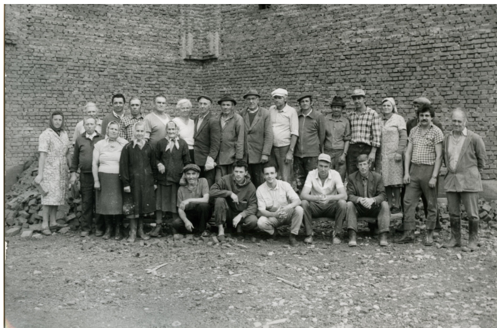
Будівельники закінчили мурування церкви
